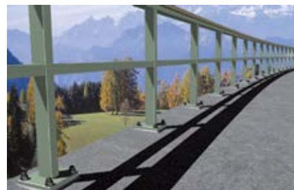
Перильные ограждения мостов
